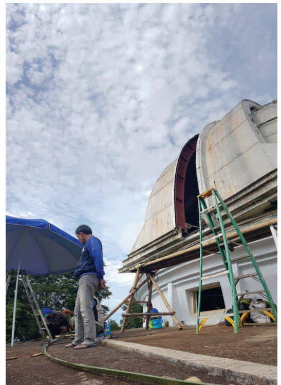
Gambar 12 (kanan). Pekerjaan pemasangan talang pada sisi luar kubah yang dilakukan oleh 3 orang teknisi Observatorium Bosscha.
